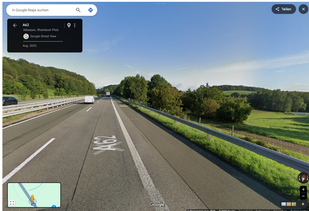
OP 6: Autobahn A 62, Blick-/Fahrtrichtung Nordwest.
