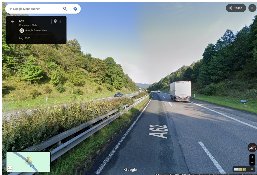
OP 2: Autobahn A 62, Blick-/Fahrtrichtung Nordwest.
