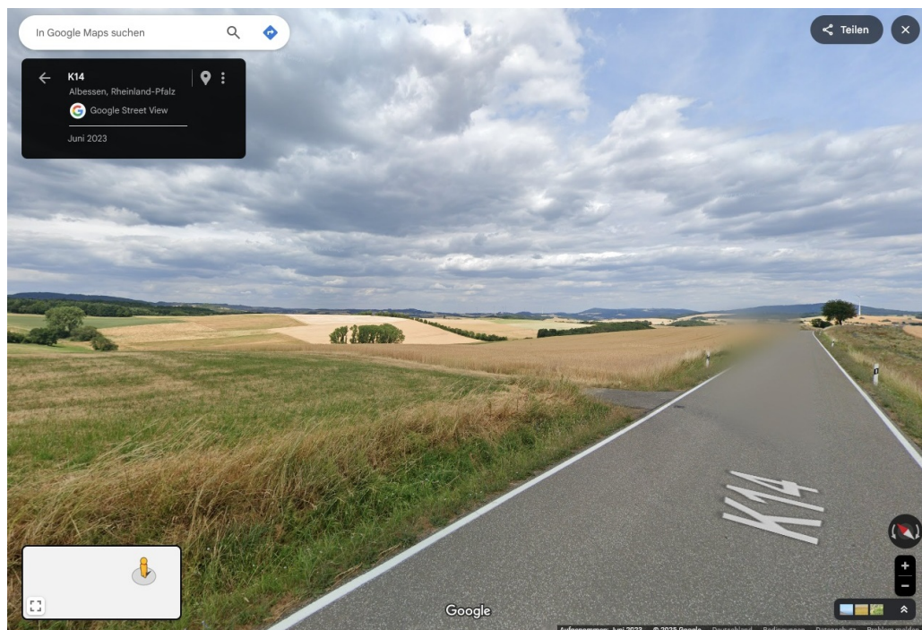
OP 10: Kreisstraße K 14, Blick-/Fahrtrichtung Ost.
