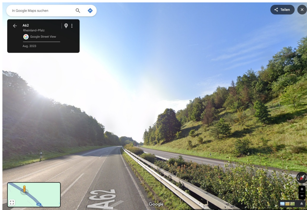
OP 1: Autobahn A 62, Blick-/Fahrtrichtung Südost.
