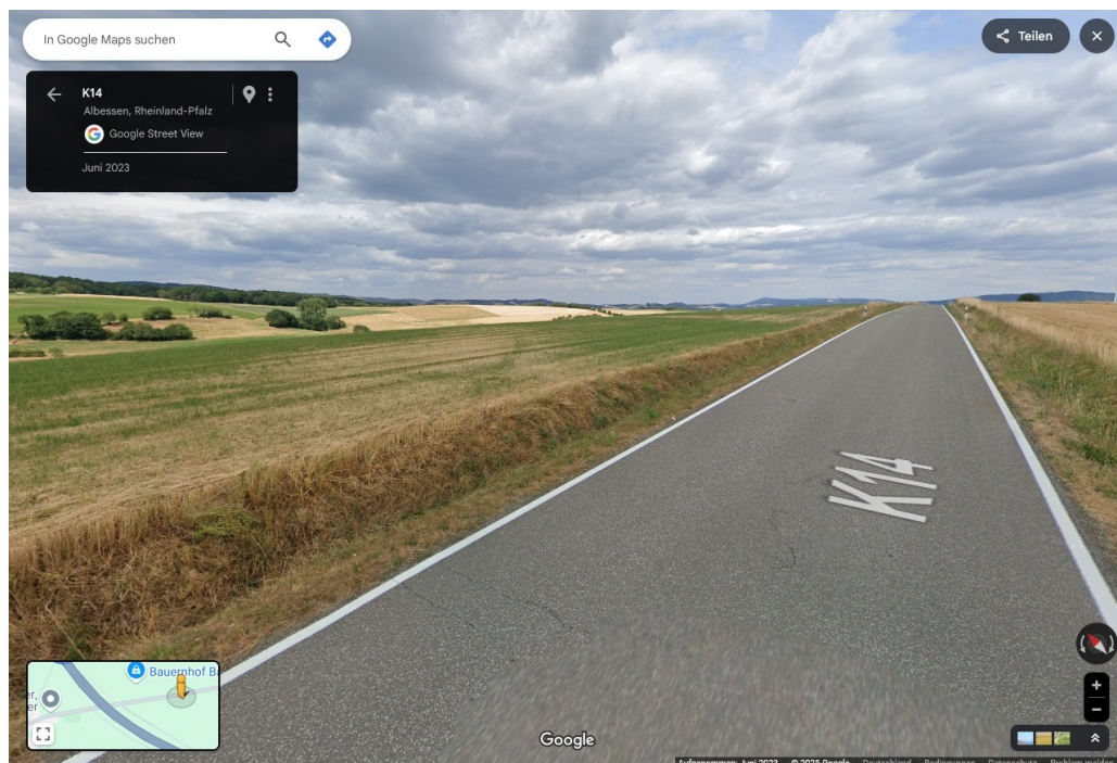
OP 9: Kreisstraße K 14, Blick-/Fahrtrichtung Ost.
