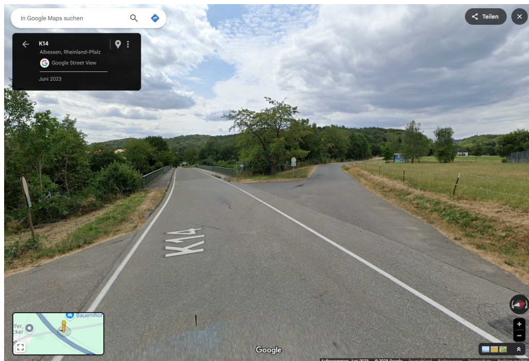
OP 8: Kreisstraße K 14, Blick-/Fahrtrichtung West.
