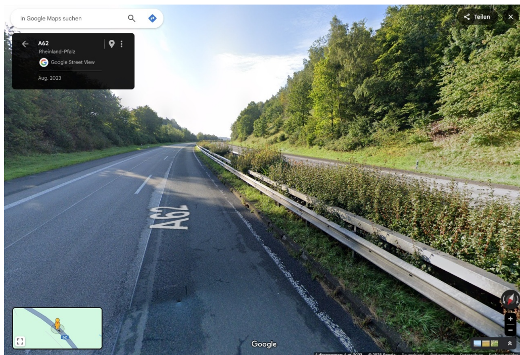
OP 2: Autobahn A 62, Blick-/Fahrtrichtung Südost.
