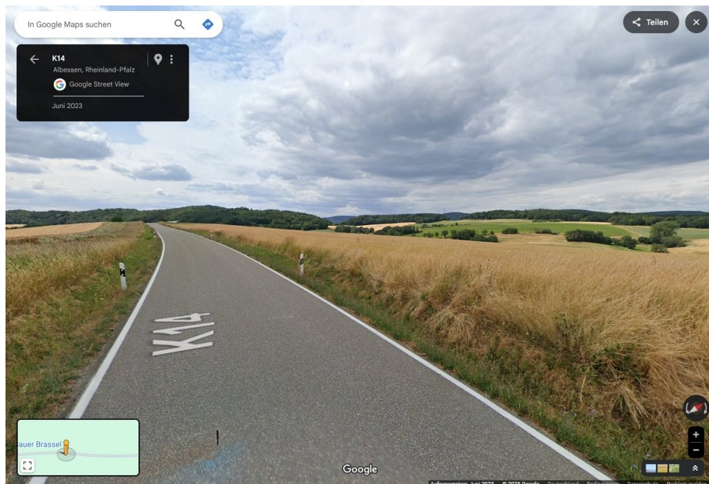
OP 11: Kreisstraße K 14, Blick-/Fahrtrichtung West.
