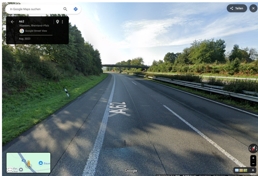
OP 7: Autobahn A 62, Blick-/Fahrtrichtung Südost.
