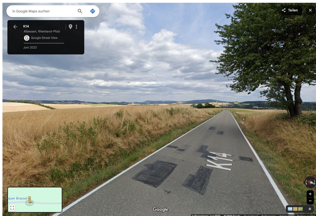
OP 11: Kreisstraße K 14, Blick-/Fahrtrichtung Ost.
