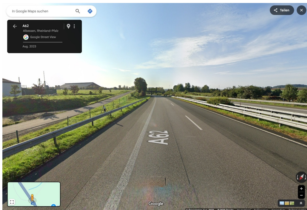
OP 6: Autobahn A 62, Blick-/Fahrtrichtung Südost.
